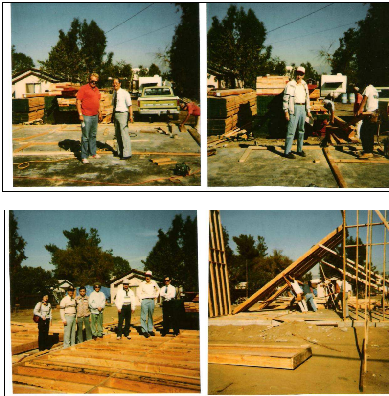
MS Quản-Nhiệm, Nhà Thầu, Ông Duckworth, quý Chấp-Sự Ngày khởi-công xây-cất
